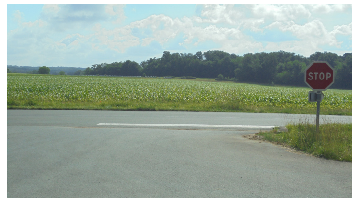
L'aménagement du raccordement à la RD 99 : panneau « stop » en sortie
